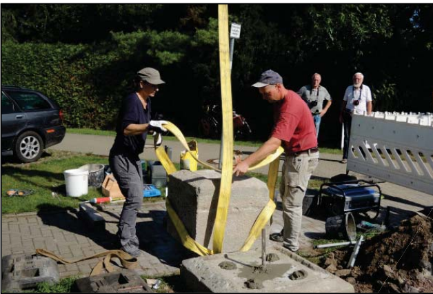
Abb. 16 (links): Der Sockelstein steht, die obere Fläche ist mit Metalldübel und Mörtel für die Montage des dahinter zu sehenden würfelförmigen Mittelteiles vorbereitet.
