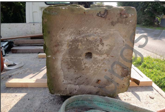
Abb. 9 (links): Der Obeliskenteil ist auf das Transportfahrzeug verladen worden. Zu sehen ist seine Unterseite mit dem zentralen viereckigen Loch zur Aufnahme eines Eisendübels.
