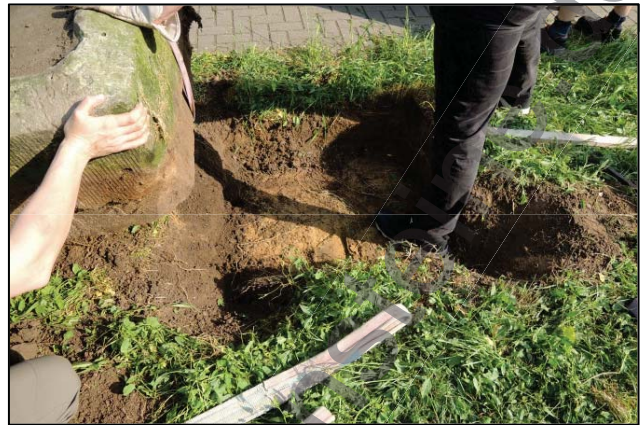
Abb. 11 (links): Beim Abheben und Verladen des Sockelsteines zeigte sich eine seitlich umlaufende Kante. Abb. 12 (rechts): Unter dem Sockelstein wurde nur ein Sandbett als Fundament vorgefunden (beide Fotos: Magnus/Ottersleben, 30.05.2017).
