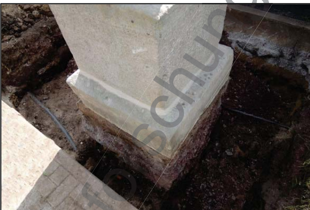
Abb. 18 (links): Das nochmal freigelegte Fundament. Alle Fugen zwischen den Meilensteinteilen sind bereits verschlossen. Zu erkennen sind im Graben zwei elektrische Erdkabel im Fundamentbereich des Meilensteins (Foto: Magnus/Ottersleben, 30.08.2017).
