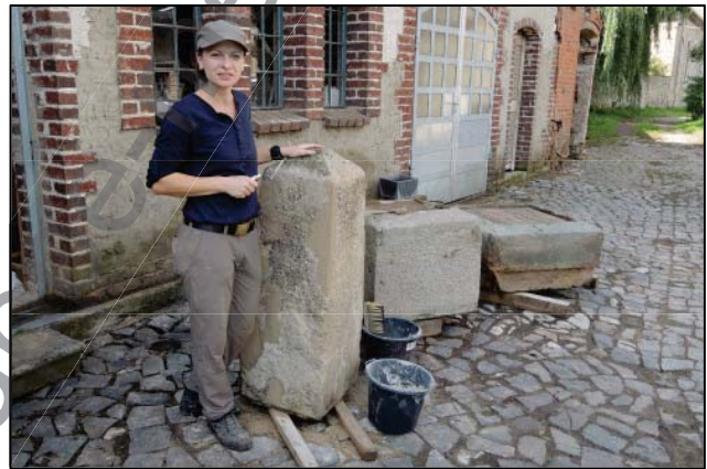
Abb. 11 (links): Beim Abheben und Verladen des Sockelsteines zeigte sich eine seitlich umlaufende Kante. Abb. 12 (rechts): Unter dem Sockelstein wurde nur ein Sandbett als Fundament vorgefunden (beide Fotos: Magnus/Ottersleben, 30.05.2017).
