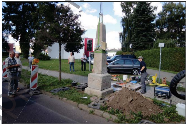
Abb. 16 (links): Der Sockelstein steht, die obere Fläche ist mit Metalldübel und Mörtel für die Montage des dahinter zu sehenden würfelförmigen Mittelteiles vorbereitet.
