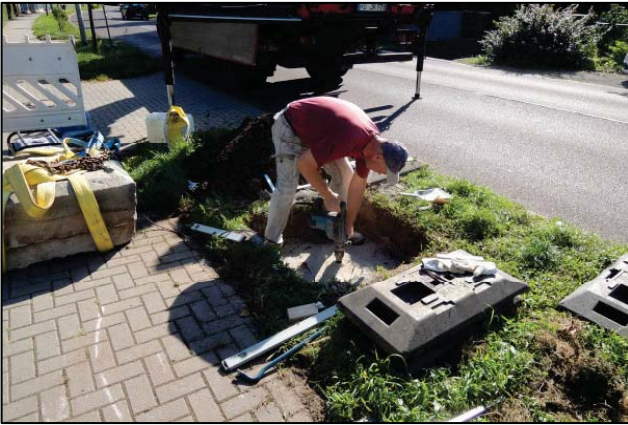
Abb. 14 (links): In das neue Fundament wird ein Loch zur Aufnahme des Metalldübels gebohrt.
