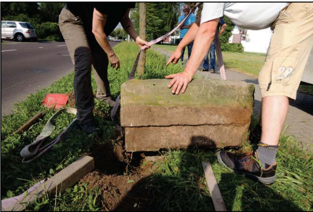
Abb. 11 (links): Beim Abheben und Verladen des Sockelsteines zeigte sich eine seitlich umlaufende Kante. Abb. 12 (rechts): Unter dem Sockelstein wurde nur ein Sandbett als Fundament vorgefunden (beide Fotos: Magnus/Ottersleben, 30.05.2017).
